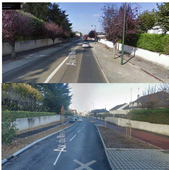
Exemple du réaménagement du boulevard du Marchal Joffre de Château-Gontier (photo 2010-2022) : redéfinition de l'axe routier avec des accotements, voies cyclables et piétonnes dédiées, plantations d'arbres de haute tige
