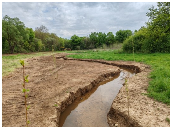
Création d'un nouveau lit méandriforme
