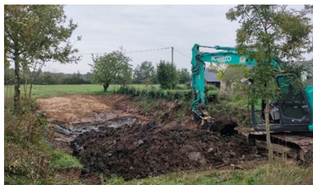
Mare pendant les travaux
